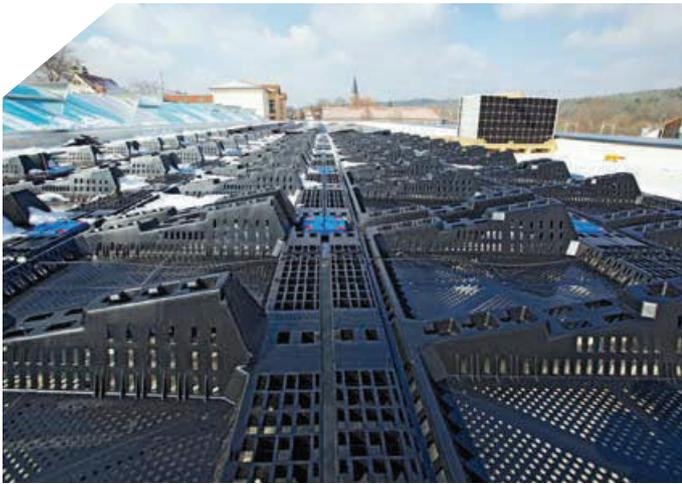
▲ Unterkonstruktion, Wartungswege und Kabelkanäle wurden allesamt auf Fixierfüße gesteckt und mit einer Abdeckplatte gesichert
