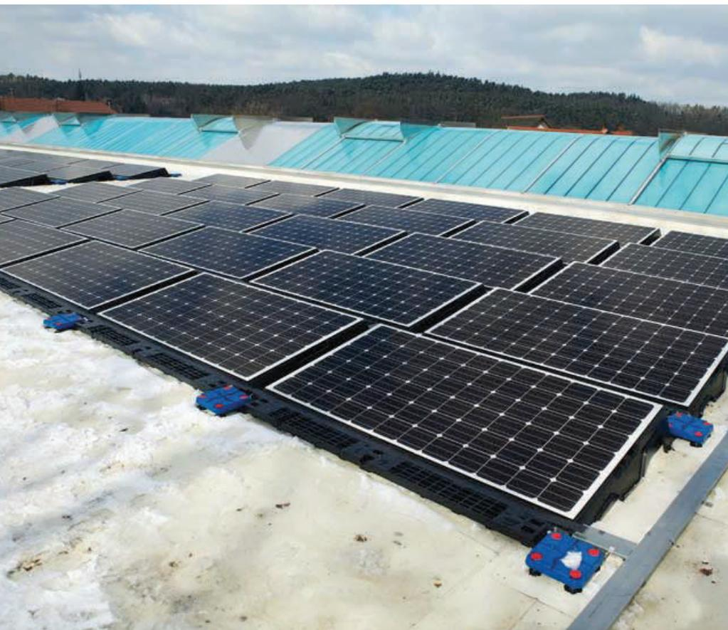
▲ Leichtes PV-System: Da die Lasten von lediglich 12,9 kg/m<sup>2</sup> flächig ins Dach eingetragen werden, konnte auf eine teure Spezialdämmplatte mit druckfesterer Oberfläche verzichtet werden
