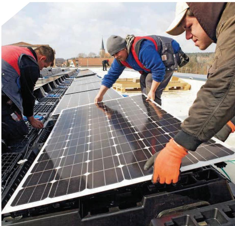
▲ Werkzeuglose Montage: Die kristallinen PV-Module des Systems werden auf die Unterkonstruktion aufgelegt und müssen dort lediglich einrasten
