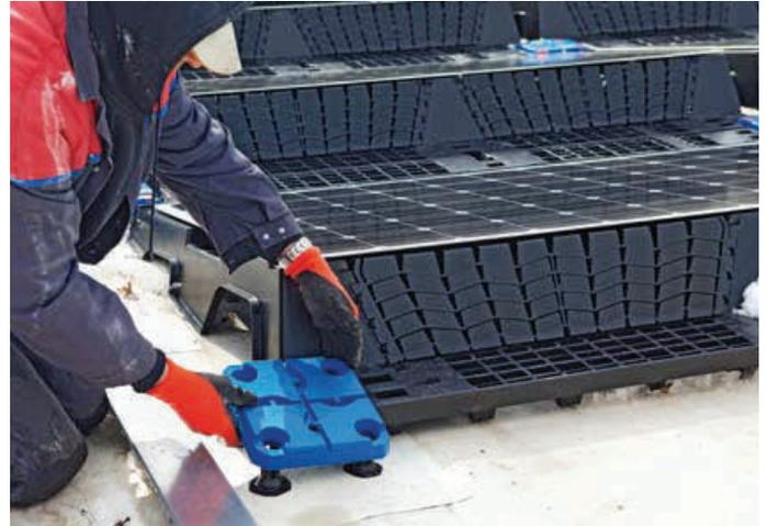
▲ Aus dem Baukasten: Die blaue Abdeckplatte fixiert die komplette Unterkonstruktion mit jeweils vier speziellen Haltestiften
