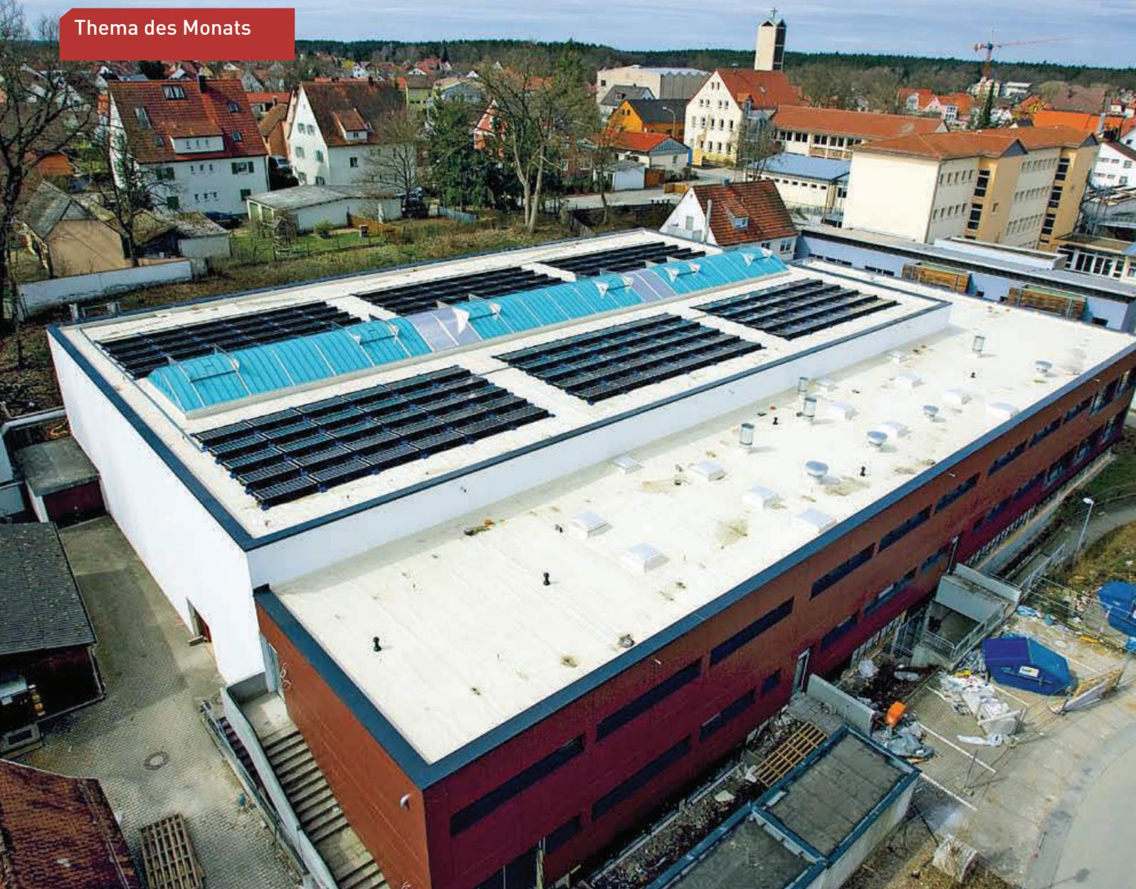
▲ Schnelle Montage: Die PV-Anlage auf dem Dach der Sporthalle besteht aus 180 Modulen und war innerhalb einer Woche komplett installiert
